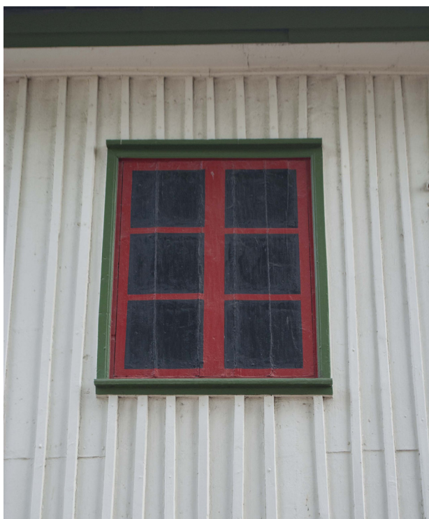
Blindfönstren på norra sidan är ett av de äldre. Här finns släta fogar och droppbleck i plåt.
